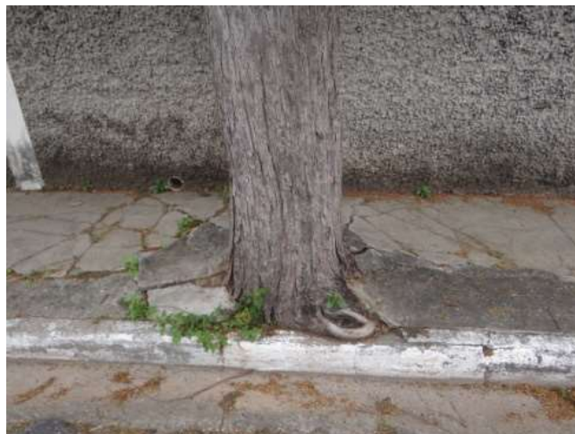
Figura 31 – Árvores demonstrando média interferência da raiz no calçamento na arborização urbana no Bairro Cavarucanguera em Taubaté – SP.
