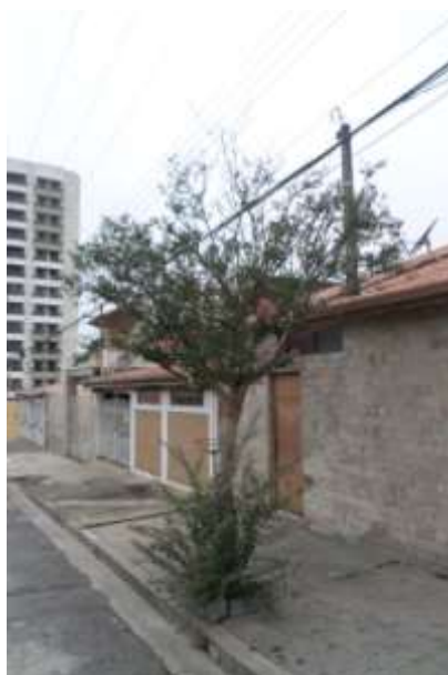
Figura 65 – Árvores com interferência na fiação na arborização urbana no Bairro Santa Luzia no município de Taubaté – SP.
